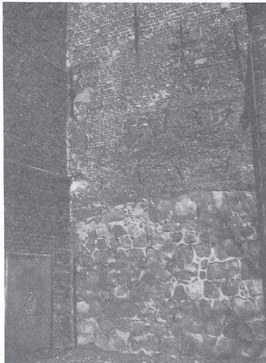
Abb. 3: Unterer Teil der Südwand des Turmes aus Feldsteinmauerwerk.
